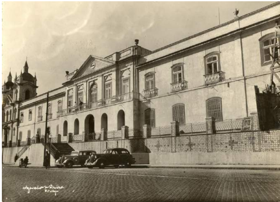
Década de 1930. Fachada principal, com destaque para escadaria de acesso. Acervo do CHC.
