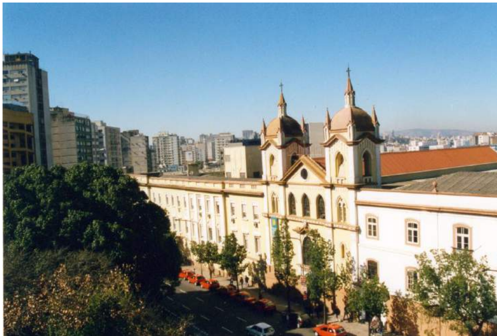
Década de 1990. Vista aérea da fachada principal. Da esquerda para a direita: Hospital São Francisco, Capela Nosso Senhor dos Passos e Pavilhão Centenário. Acervo do CHC.
